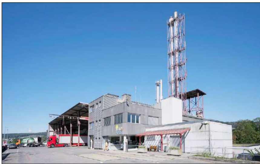
Die heutige Anlage soll während der Bauzeit in Betrieb bleiben. Foto: zVg
