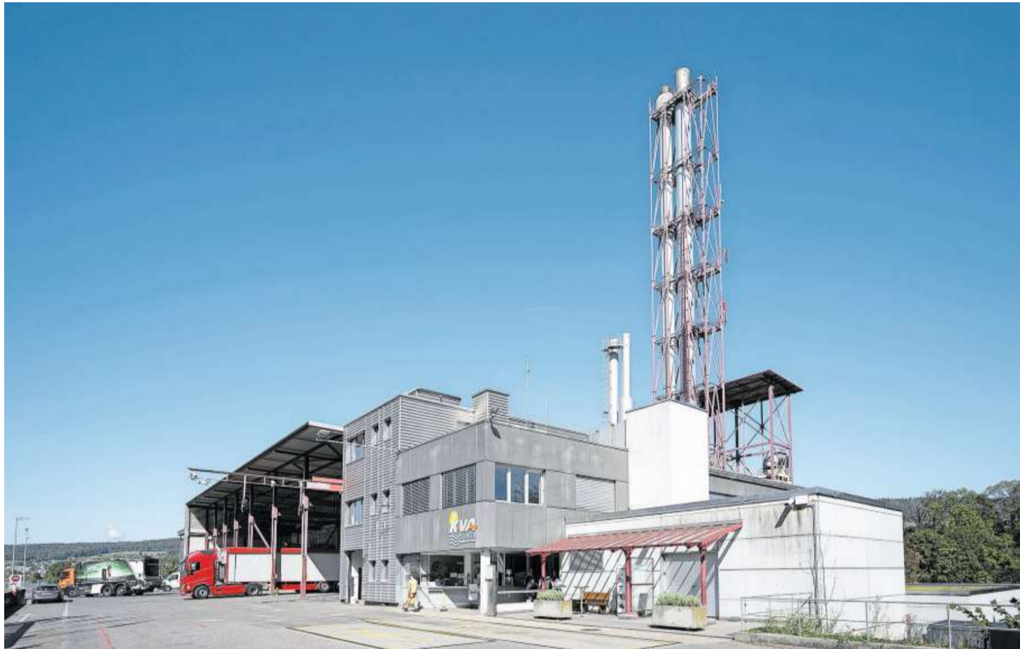
Die heutige Kehrrechtverbrennungsanlage soll während der Bauzeit in Betrieb bleiben.
