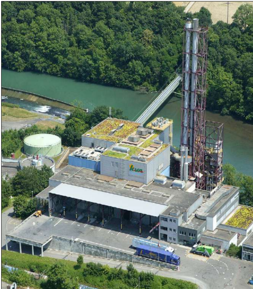
Die KVA in Turgi braucht nach 50 Jahren eine Frischzellenkur. Foto: zVg
